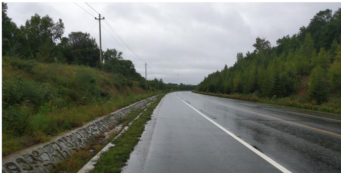
路基边坡绿化措施
