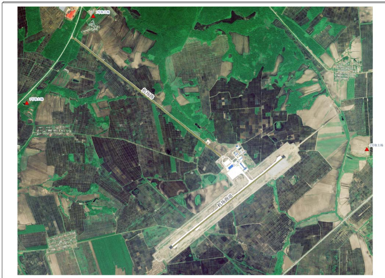
施工完成后（20140604）卫片
