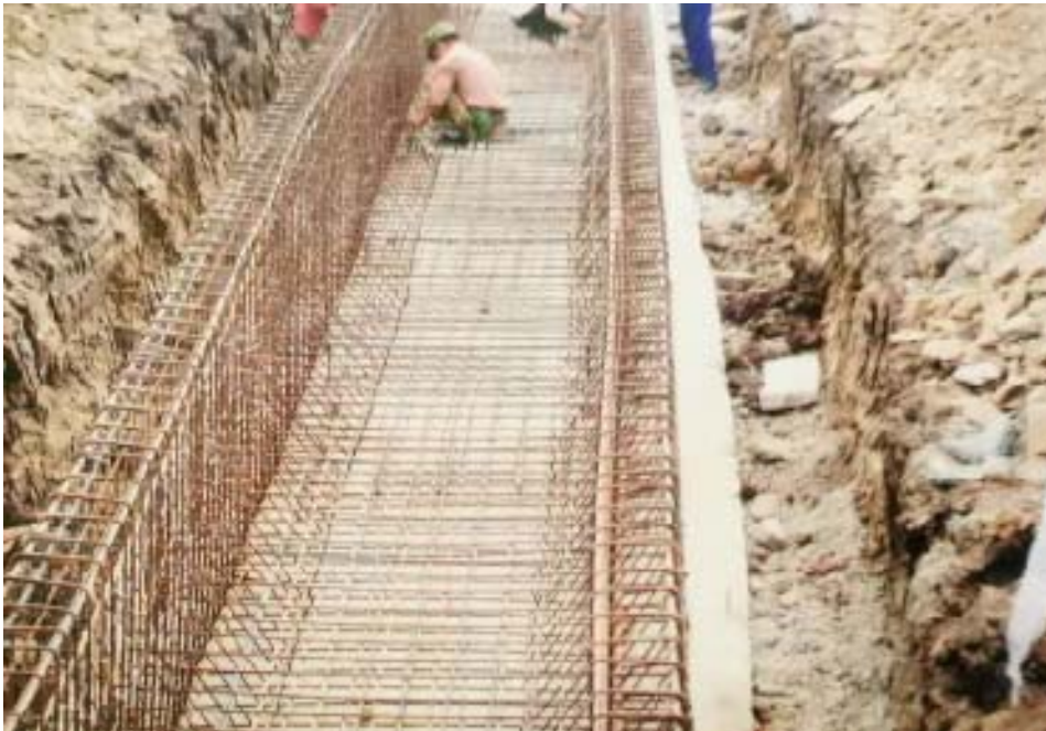
盖板排水沟施工
