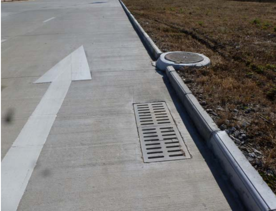
附属生产办公区地下排水
